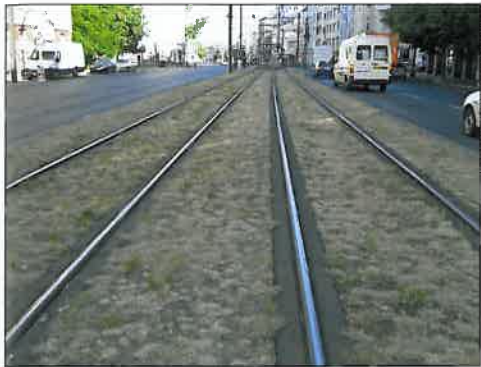
Abb. 3: Vertrocknete Gräser im Rasengleis nach langer Trockenheit.
