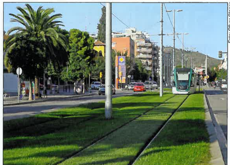
Abb. 2: Selbst in südlichen Ländern kommen bei neuen Stadtbahnsystemen wie auf dem Bild in Barcelona Rasengleise zum Einsatz.
