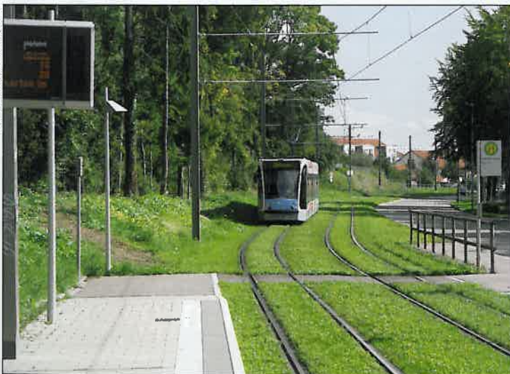
Abb. 1: Auf der Ulmer Neubaustrecke nach Böfingen wurde ein hochliegendes Rasengleis verwendet.
