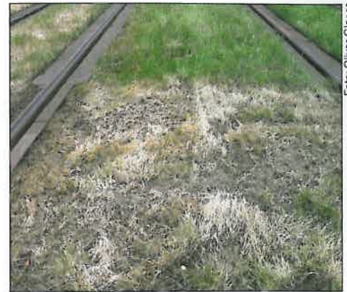
Abb. 9: Rasengleis ist nicht gleich Rasengleis, zwei unterschiedliche Bauarten unter den absolut gleichen Randbedingungen nach längerer Trockenphase.
