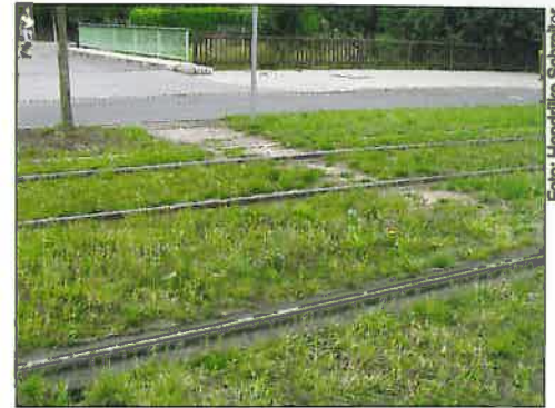
Abb. 5: Durch häufige Fußgängerquerung entstehen Trampelpfade.
